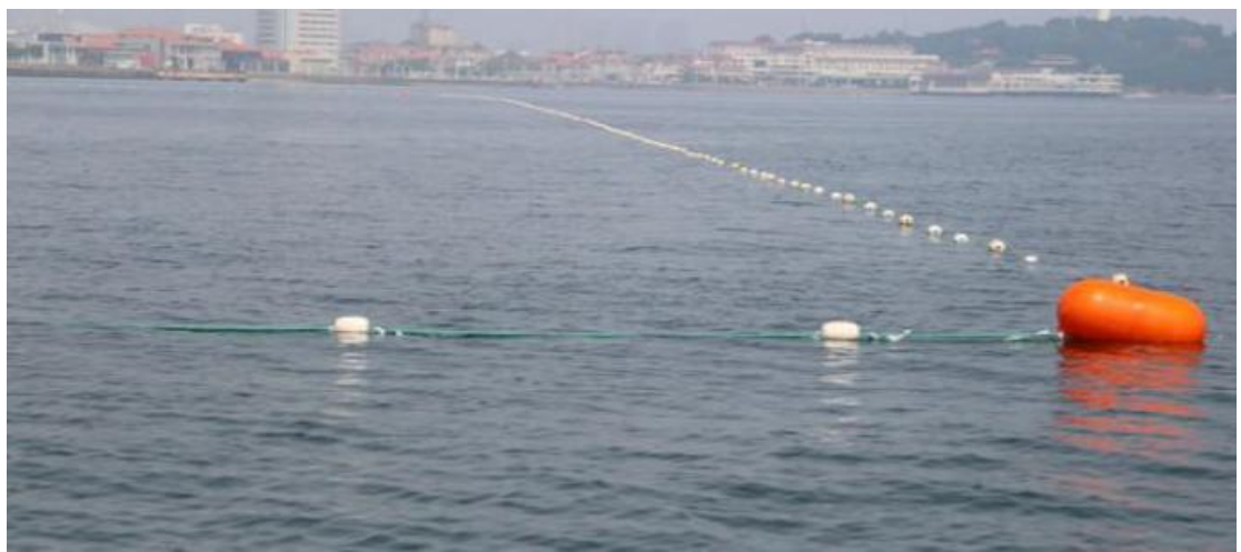
图 1.2.3- 5 拦鲨网安装后示意图
