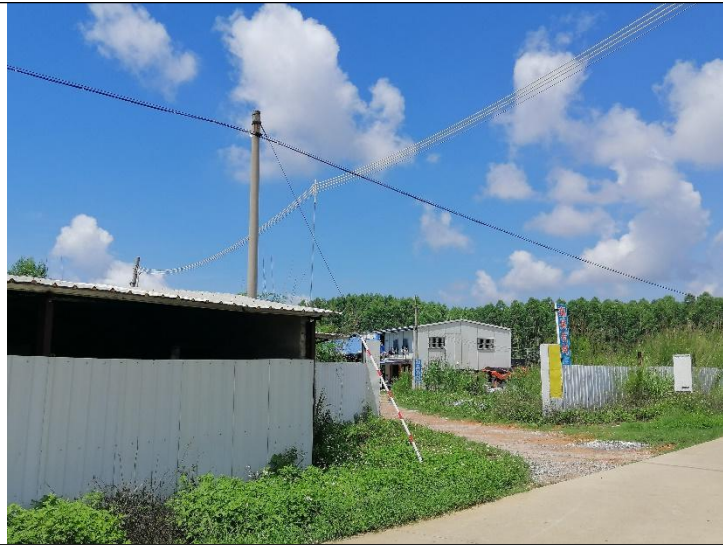
项目南侧石材厂
